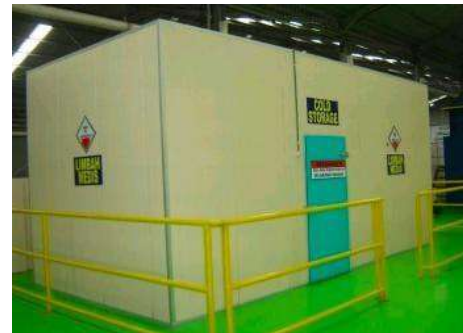
Contoh ruang pendingin untuk penyimpanan Limbah B3 Sumber Permenlhk no 56 tahun 2015
