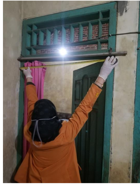
Pengukuran Luas Ventilasi
