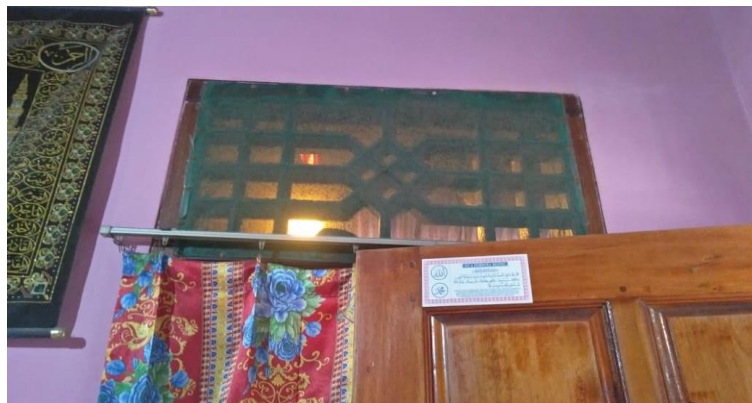
Ventilasi rumah responden yang memasang kawat kasa
