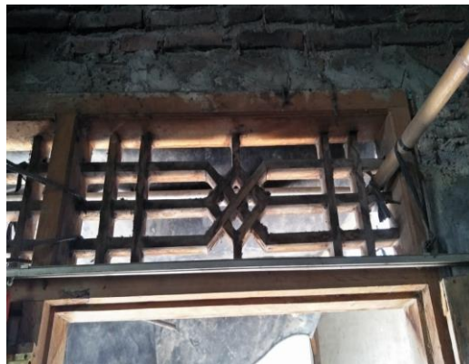
Ventilasi rumah responden yang tidak menggunakan kawat kasa
