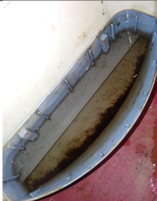
2. Kontainer yang ditemukan jentik (Dispenser)
