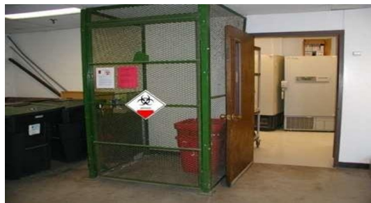
Gambar 2.1 fasilitas penyimpanan limbah B3 dari fasilitas pelayanan kesehatan dalam ruangan yang dilengkapi dengan pembatas akses (kerangkeng)
