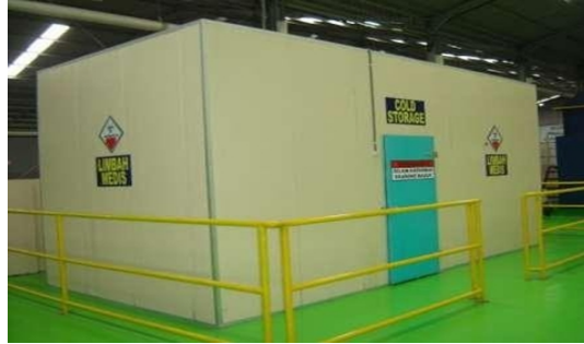
Gambar 2.2 ruang pendingin untuk penyimpanan limbah B3 berupa Limbah infeksius, benda tajam, dan patologis Sumber: PerMenlhk P.56/2015
