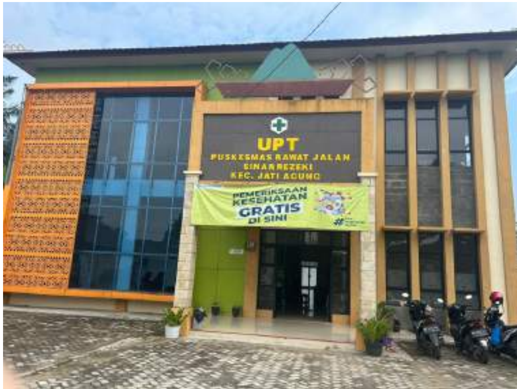
Lampiran 13. Puskesmas Sinar Rejeki Kec. Jati Agung Kab. Lampung Selatan
