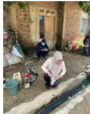
Peninjauan selokan mampet
