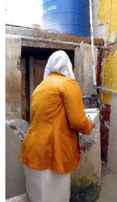
Sarana Air Bersih (Sumur Gali)
