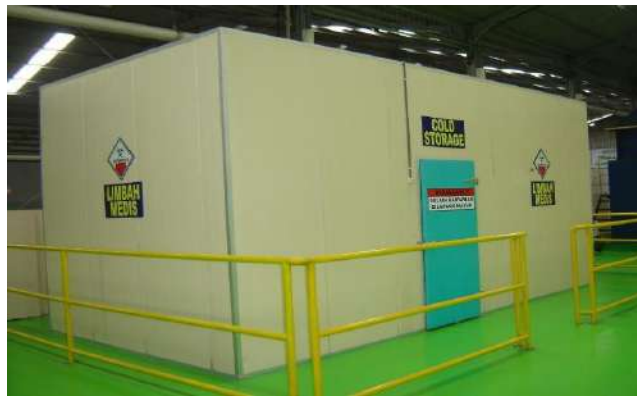
Gambar 2.5 Contoh ruang pendingin untuk penyimpanan Limbah B3 Sumber Permenlhk no 56 tahun 2015
