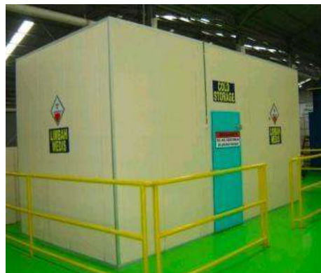
contoh ruang pendingin untuk penyimpanan limbah b3 sumber permenlhk no 58 tahun 2015
