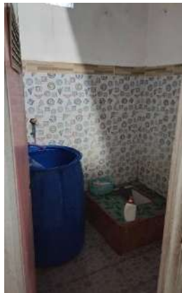
Kondisi sarana Jamban
