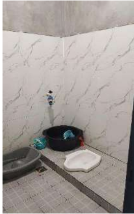
Kondisi sarana jamban
