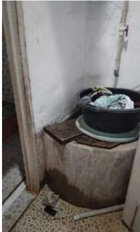
Kondisi sarana Sumur Gali
