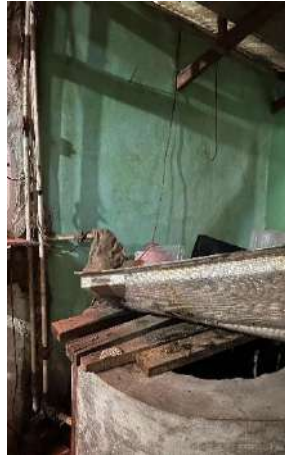
Kondisi sarana Sumur Gali
