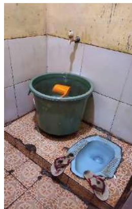
Kondisi sarana jamban
