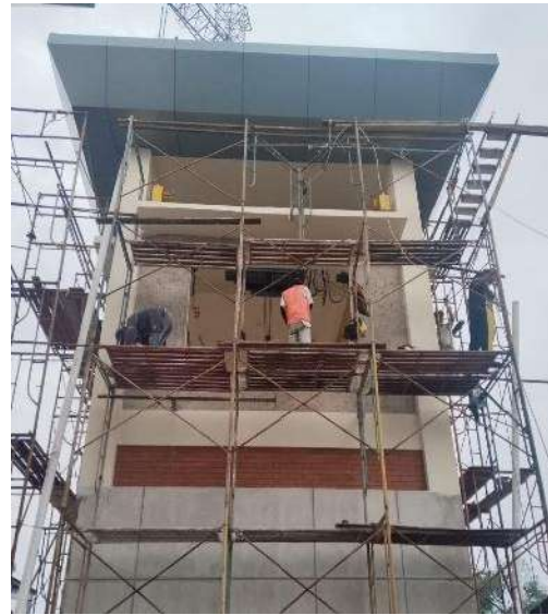
Pemasangan plaster untuk dinding
