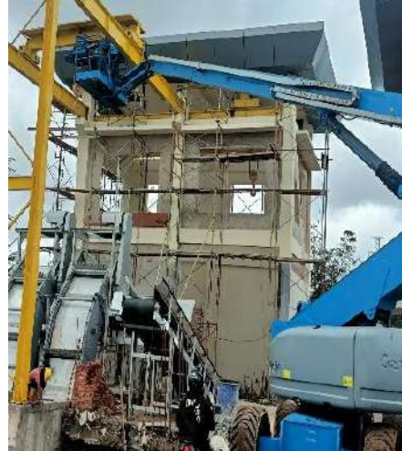
Pekerjaan acian dinding
