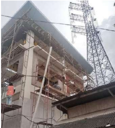
Pemasangan dinding bata merah
