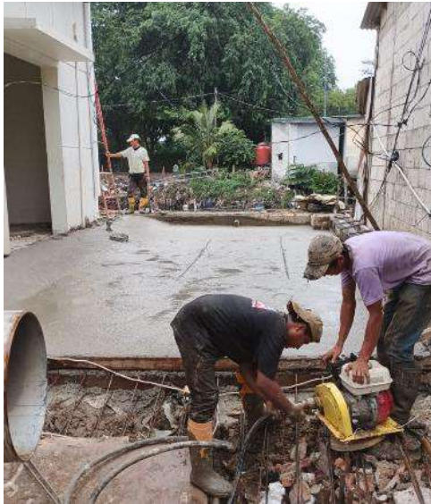
Pengerjaan pembuatan lantai
