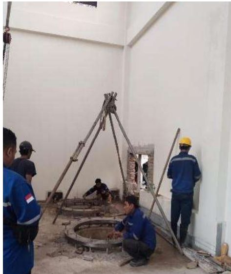
Pemasangan pipa besi didalam rumah pompa
