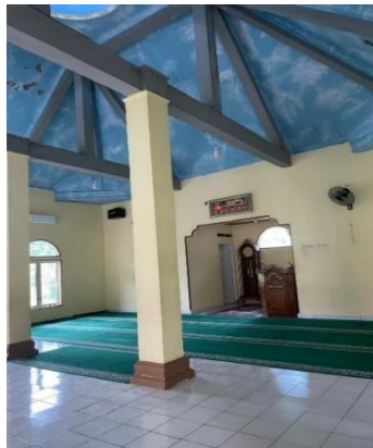
Kondisi Bangunan Dalam Masjid Al - Muttaqin
