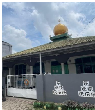
Kondisi Bangunan Masjid Al – Ulya
