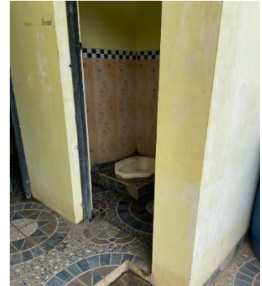
Kondisi jamban Masjid Nurul Falaah
