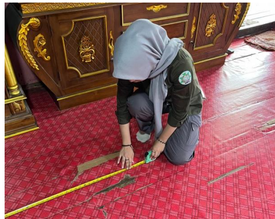
Pengukuran Luas Lantai
