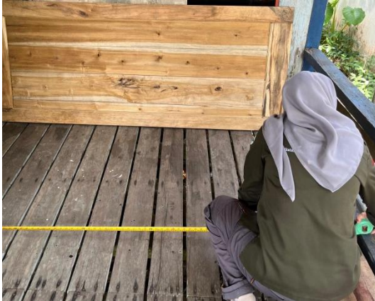
Pengukuran Luas Lantai
