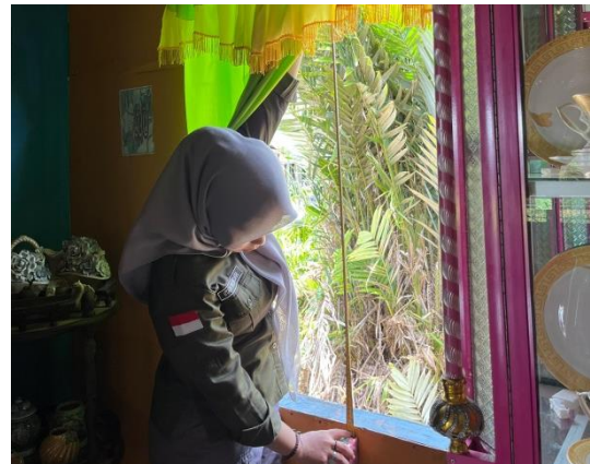
Pengukuran Luas Ventilasi
