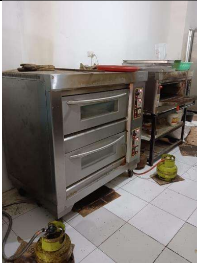
Kondisi pada Pabrik Roti C
