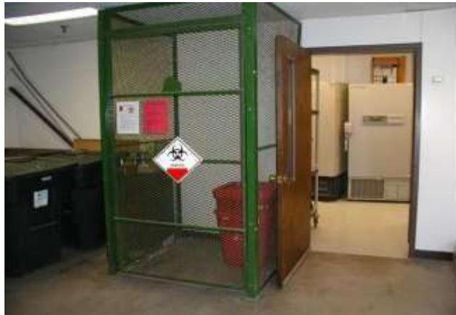
Gambar 4. Contoh fasilitas penyimpanan Limbah B3 dari fasilitas pelayan kesehatan dalam ruangan yang dilengkapi dengan pembatas akses (kerangkeng). Sumber Permenlhk no 56 tahun 2015
