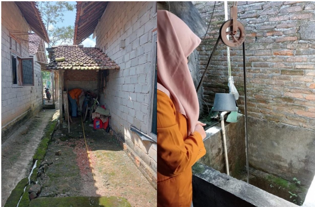
Gambar 6 Pengukuran jarak septictank kesumber air bersih
