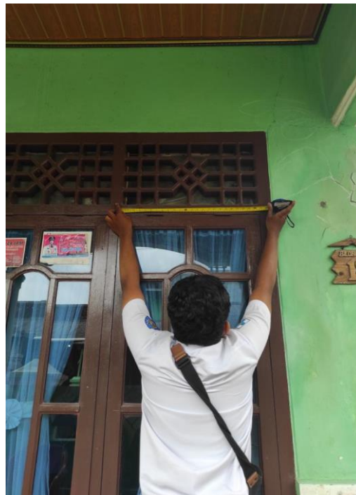
Pengukuran Ventilasi Dengan Menggunakan Alat Ukur Meteran di Rumah Penderita Tb Paru Wilayah Kecamatan Sukabumi Kota Bandar Lampung
