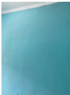
Dinding pada Ruang Rawat Inap
