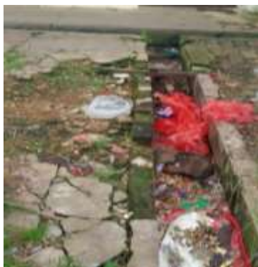
Gambar 5. Drainase tidak lancar
