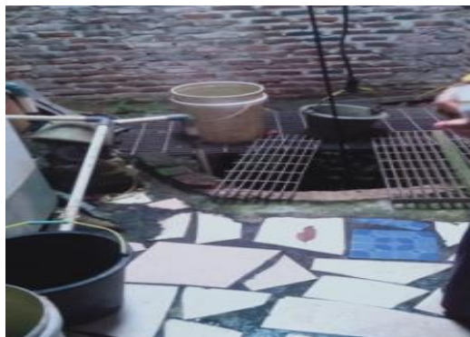
Gambar 5. Sumur gali nomor 6 yang tidak memiliki bibir sumur
