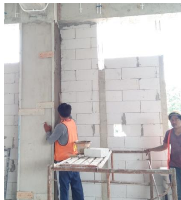
Pekerjaan pemasangan bata
