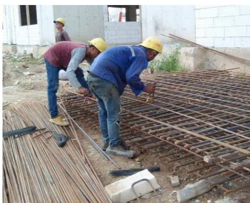
Perakitan besi tulangan
