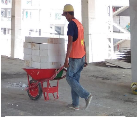
Pemindahan material hebel menggunakan gerobak dorong
