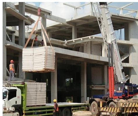
Pemindahan hebel menggunakan crane
