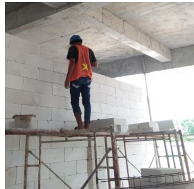
Pemasangan dinding bagian atas
