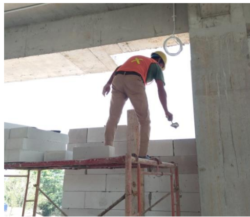
Pekerjaan pemasangan bata
