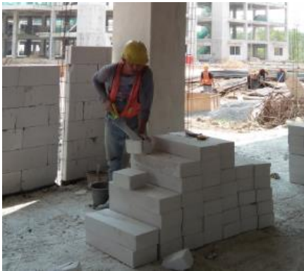
Pekerjaan cutter hebel
