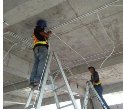
Pekerjaan Instalasi Listrik
