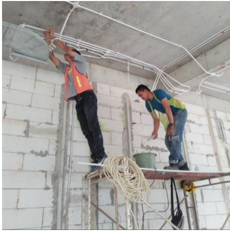
Pekerjaan Instalasi Listrik
