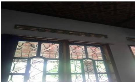
Kondisi ventilasi dan jendela
