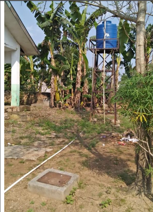
Kondisi sarana air bersih yang menggunakan sumur bor
