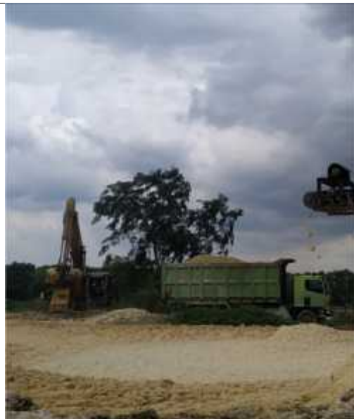
pengangkutan sampah ongkok menuju tempat penampungan akhir dinbatu eskavator
