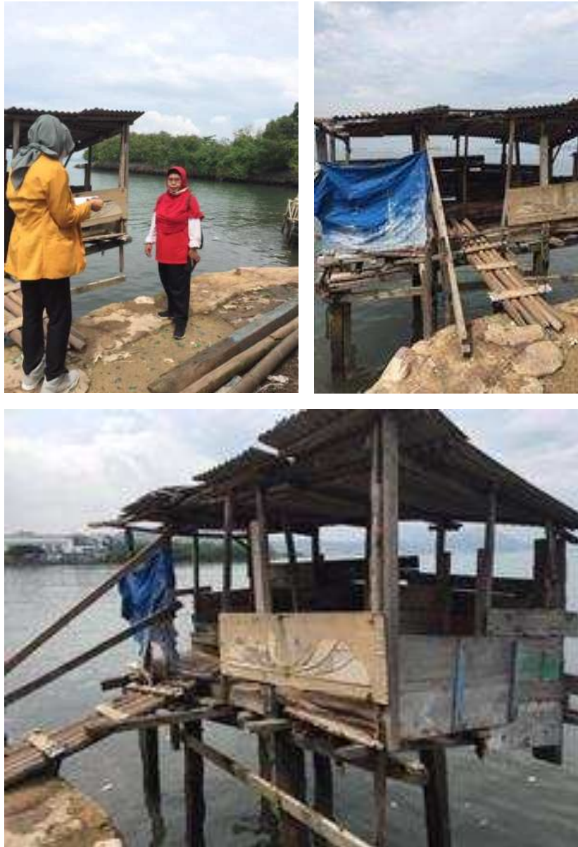
Pengecekan jamban Kondisi Jamban panggung Jamban Panggung
