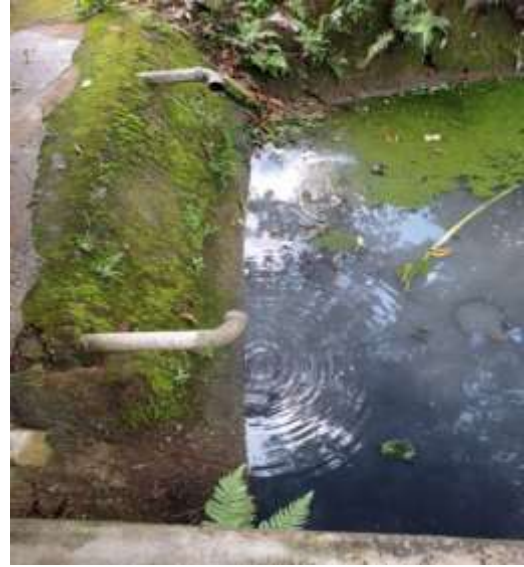
Dokumentasi tempat pembuangan air limbah
