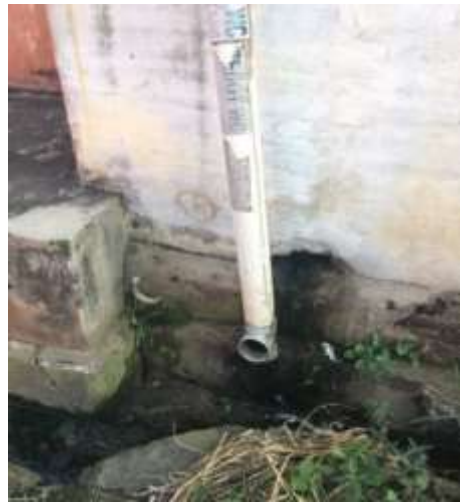
Dokumentasi tempat pembuangan air limbah
