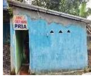
Mengobservasi Kontruksi Bangunan
