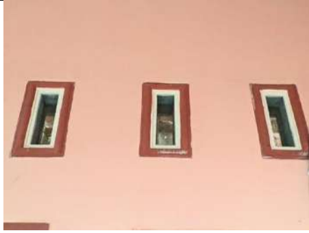
Ventilasi rumah yang menggunakan kawat kasa
