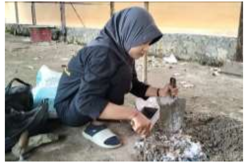
Pencampuran Adukan Dengan Cacahan Plastik
