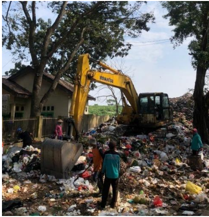
Proses perataan sampah menggunakan alat berat ekskavator
