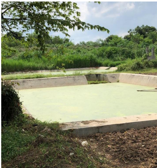
Kolam lindi yang berada di belakang lokasi TPAS
