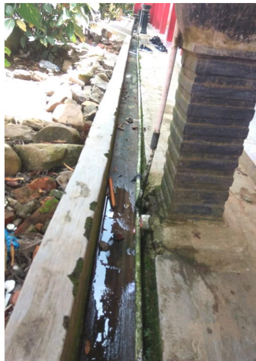
Saluran Pembuangan Air Limbah
