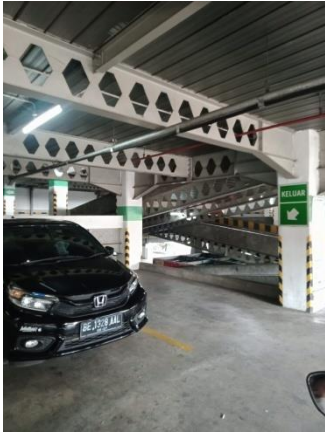
Gambar 1. Parkir Upperground MBK tampak depan
