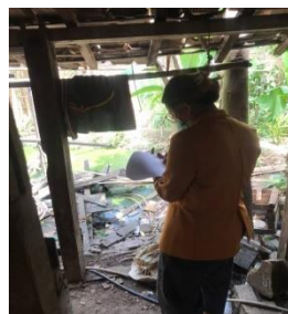
Keadaan SPAL Rumah Responden
