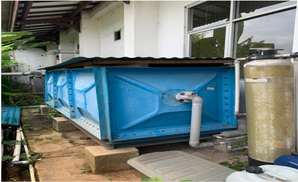
Gambar IPAL Domestik UPTD Laboratorium Lingkungan DLH Provinsi Lampung
