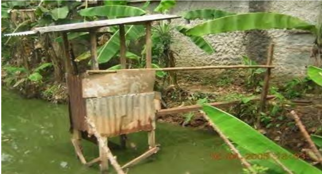
Gambar 2. Jamban diatas balong (empang)
