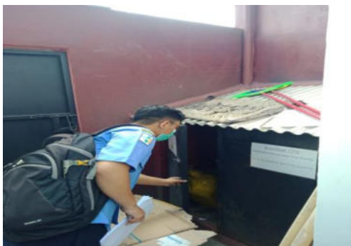
Pengecekan Kondisi Bangunan Fisik TPS
