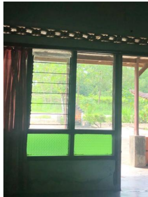
Keadaan Ventilasi & Jendela Rumah
