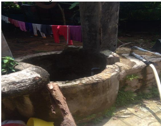
kondisi sumur gali yang tidak memenuhi syarat
