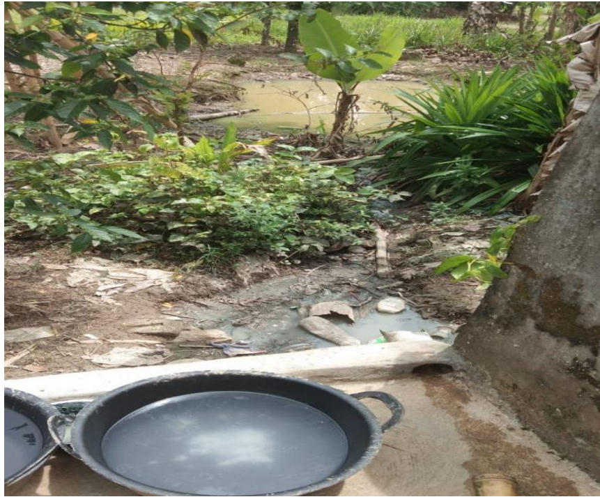
Saluran Pembuangan Air Limbah (SPAL) yang dialirkan ke Lubang Resapan di Wilayah Kerja Puskesmas Branti Raya
