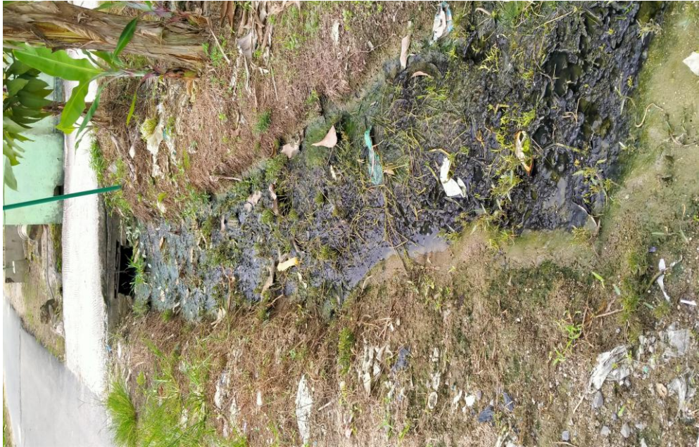
Saluran Pembuangan Air Limbah (SPAL) yang dialirkan ke siring yang tidak tertutup
